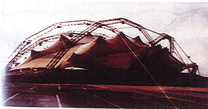
Hình 6.31 : Mái bằng "vải" Polymer - polyester
