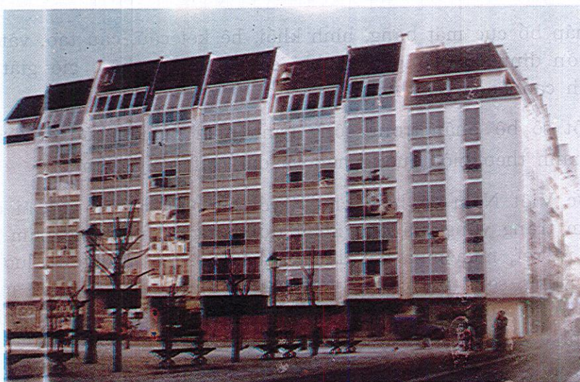
Hình 8.16 : Nhà ở tại Bordeaux (Pháp)
