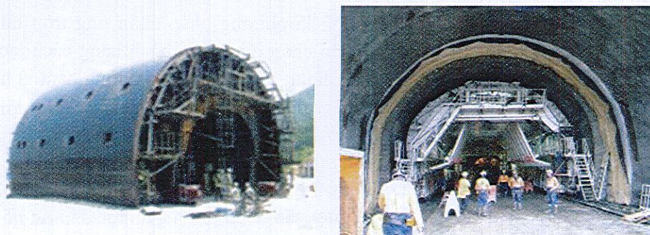
Hình IX.3: Ván khuôn lắp dựng vỏ hầm [29].
