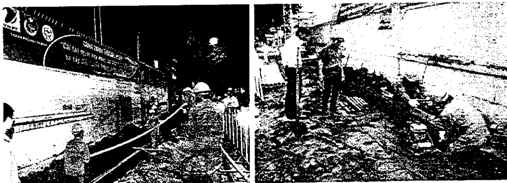
Hình VI.12: Công trình ngầm hóa đường Lê Thánh Tôn (TP. Hồ Chí Minh) theo giải pháp cổ điển [22].
