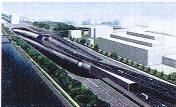
Hình IX.13: Công trình đường hầm khu Izumi Daii Hinagawa Chuo (Nhật) được thi công bằng phương pháp URUP, 6/2009-1/2012 [2].
