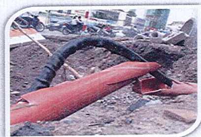
Hình VI.6: Hạ ngầm sử dụng ống nhựa PVC [4].
