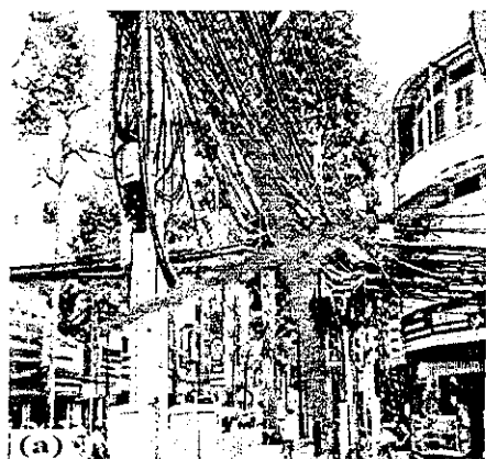
Hình VI.11: (a) Dây cáp điện, thông tin chằng chịt trước khi công trình thực hiện; (b) Mặt tiền thoáng đãng, sạch đẹp, mỹ quan sau khi ngầm hóa [22].
