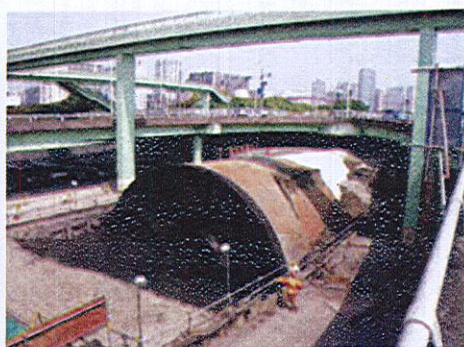
Hình IX.12: Thiết bị thi công bằng phương pháp URUP [2].
